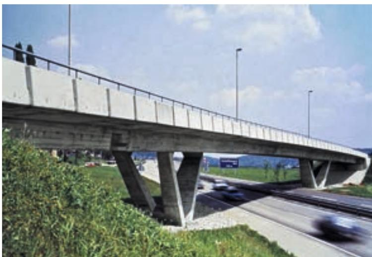
**Bild 1-1:** Die dynamisch geprüfte, weltweit erste teilweise vorgespannte Leichtbetonbrücke bei Schaffhausen.
